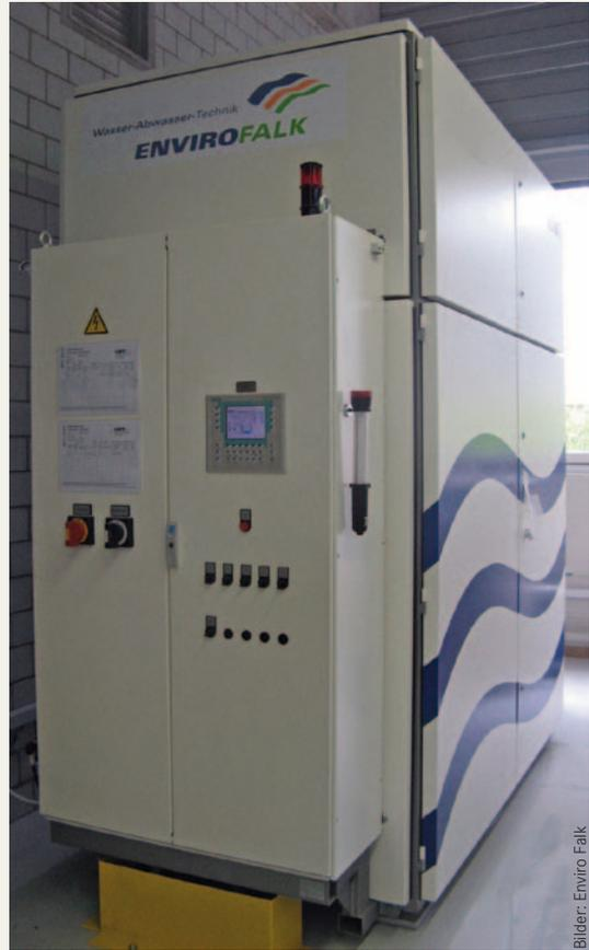
Die Verdampfungsanlage arbeitet mit einer Leistung von 300 l/h
