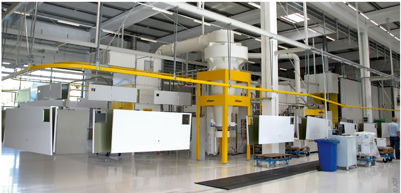
In der Anlage werden Stahl- und Aluminiumteile für den Innenbereich beschichtet. Die Beschichtungsanlage nimmt in etwa die Hälfte der Produktionsfläche der Halle ein. Platz für eine weitere Anlage ist eingeplant.
