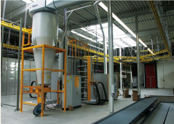
▲ Direkt neben der Automatikkabine entsteht noch eine Großteilekabine
